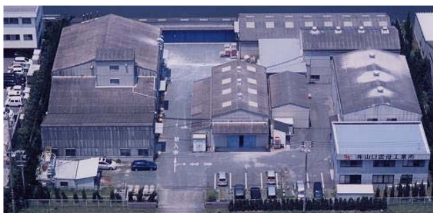
豊橋工場 敷地面積: 約 5,000 m 2
